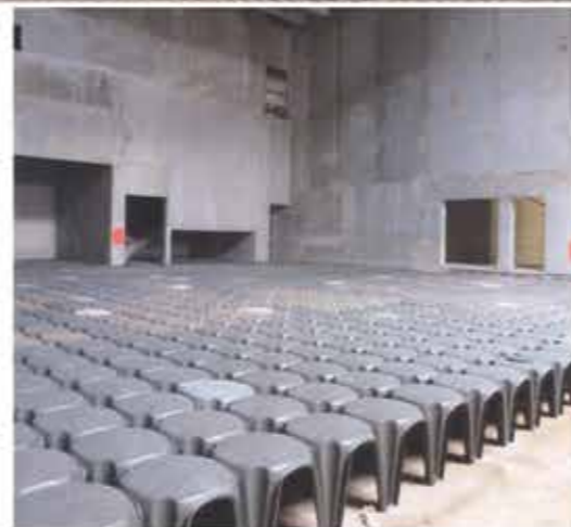
Restauro edificio scolastico
