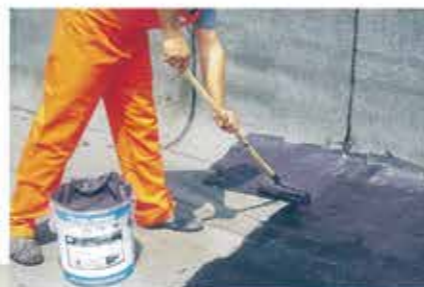
Per riparare vecchie guaine bituminose
