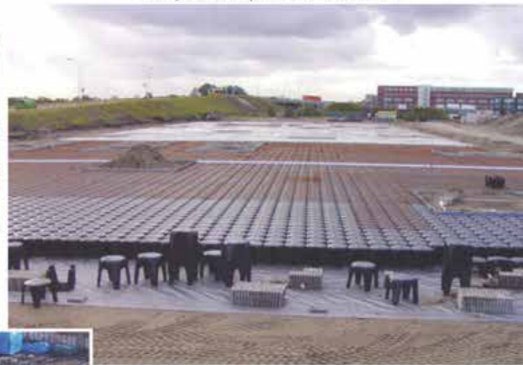
Intercapedine aerata per edificio ad uso industriale
