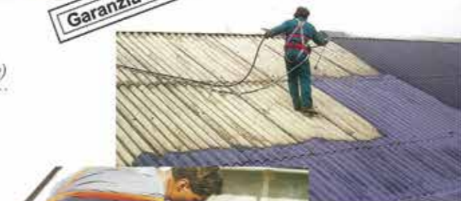
Applicazione e spruzzo (tipo Airless) per grandi superfici
