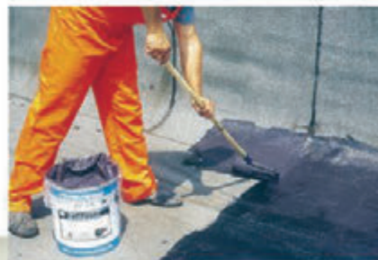
Per riparare vecchie guaine bituminose
