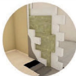
Pareti perimetrali in muratura isolate con facciata ventilata
