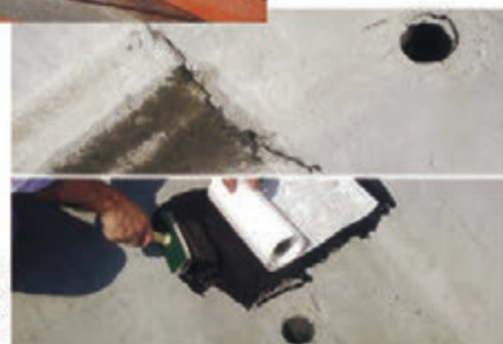
Riparazione impermeabile di fessure: in foto la riparazione di una fessura su guaina bituminosa in prossimità del bocchettone di scarico usando Elastik e Supporto Antifessura
