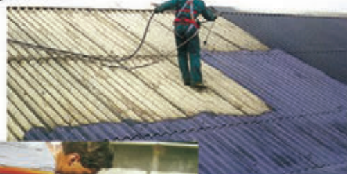
Applicazione e spruzzo (tipo Airless) per grandi superfici
